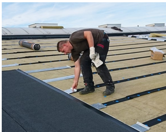
Bild 3. Herausziehen der Trennbleche (Fotos: Kebulin-Gesellschaft Kettler GmbH & Co. KG)
