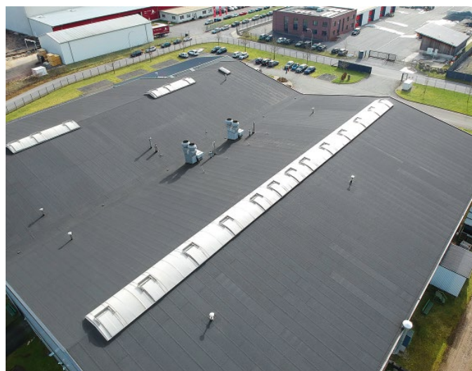
Bild 1. Werkhalle der Lancier Cable GmbH in Drensteinfurt: Blick auf die fertiggestellte Dachfläche
