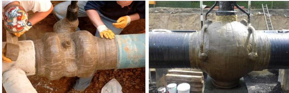
Das **Kebu Petro-Band A303** ist ein kaltverarbeitbares Korrosionsschutzband. Das **Kebu Petro-Band A303** erfüllt bei einer dreilagigen Applikation die Anforderungen der DIN EN 12068 und der DIN 30672, Belastungsklasse A, maximale Dauerbetriebstemperatur bis 30 °C.
