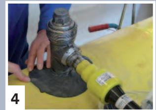
**4** Gegebenenfalls Hausanschluss vervollständigen. Armatur auf ca. 50°C vorwärmen und Ausschnitt der Werksumhüllung bündig mit **Kebutyl-Kitt** ausfüllen.
