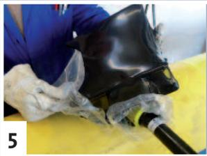
**5** Staubschutzfolie aus dem Formteil herausziehen, dabei den fließförmigen Kleber im Formteil belassen.
