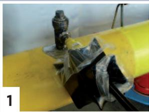
**1** Schrumpfschlauch und das **Kebulen-Schrumpfformteil S** auf die Anschlussleitung schieben. Danach ist der Hausanschluss fachgerecht herzustellen.
