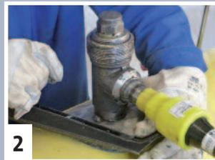
**2** Ausschnitt der Werksumhüllung abschrägen, Ecken mit geeignetem Werkzeug ausrunden (z.B. Raspel mit halbrundem Blatt).
