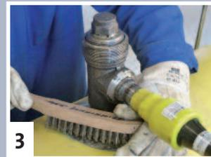
**3** Zu umhüllenden Bereich reinigen, angrenzende Werksumhüllung aufrauen (z.B. mit Handdrahtbürste), Staubreste entfernen.
