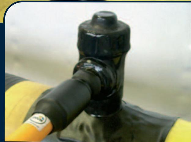
Wärmeschrumpfendes Formteil nach DIN EN 12068,
