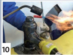
**10** Kleberseite der 1. Hälfte der geteilten Abdeckung mit Flamme aktivieren, Abdeckung positionieren...
