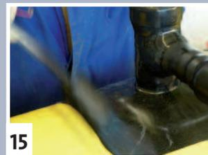
**15** Die fertig installierte Umhüllung muss überall eng anliegen.
