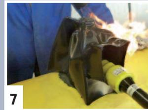
**7** Das **Kebulen Schrumpfformteil S** mit weicher Flamme von oben mit kreisförmiger Bewegung schrumpfen. Die Position erforderlichenfalls mit der Hand korrigieren (Schutzhandschuh verwenden).
