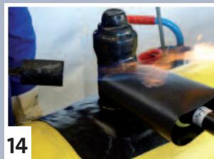
**14** Schrumpfschlauch über die Anschlussleitung schieben und gleichmäßig in Umfangsrichtung schrumpfen.
