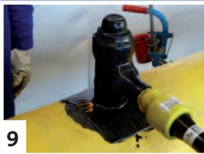
**9** Das fertig geschrumpfte **Kebulen-Schrumpfformteil S** muss überall eng anliegen.
