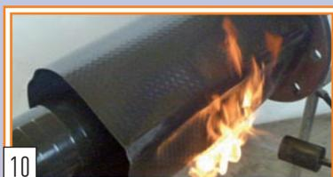
10 Schrumpfschlauch oben in der Mitte beginnend in Umfangsrichtung mit weicher Propangasflamme auf den Flansch schrumpfen.
