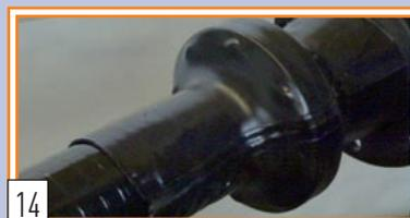
14 Der Schrumpfschlauch muss überall gleichmäßig eng anliegen.
