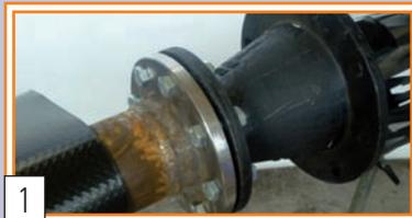
1 Den Schrumpfschlauch C 50-F vor dem Zusammenbau des Flansches über das Rohr schieben.
