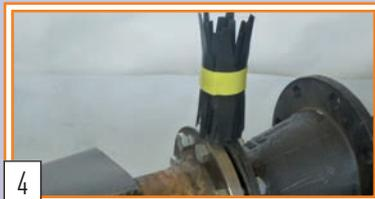
4 Den äußeren Klebestreifen der Schutzeinlage lösen und Schutzeinlage abwickeln.
