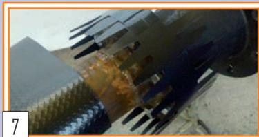
7 Schutzeinlage um die Flanschverbindung herumziehen und überlappend mit dem Klebestreifen fixieren.
