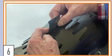
6 Schutzeinlage mit dem Kleber mittig auf die Flanschverbindung kleben.
