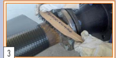
3 Verunreinigungen und Korrosionsschutzfarbe abbürsten.
