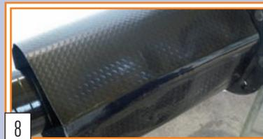
8 Den Schrumpfschlauch über die Schutzeinlage schieben.
