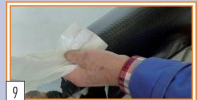
9 Staubschutzfolie entfernen und die Schweißnaht des Schrumpfschlauchs auf 3 Uhr positionieren.
