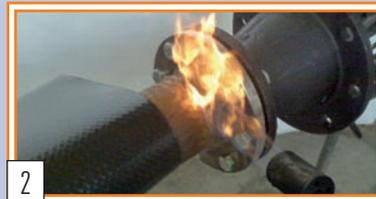
2 Flansche und Rohranschlüsse mit Hilfe einer Propangasflamme trocknen.
