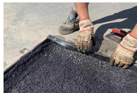
Das **Corabit Fugenband** ist ein für den Straßenbau entwickeltes anschmelzbares Fugenband auf Bitumenbasis.
