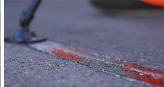
**Corabit R** ist eine polymermodifizierte, bitumenhaltige Rissmasse gemäß TL/TP Fug-StB 15 und kommt speziell bei der Sanierung von Rissen (auch Oversealbending) in Asphalt- und Betonbelägen, sowie bei ausgemagerten Straßenbelägen ohne besondere chemische Beanspruchung zum Einsatz.
